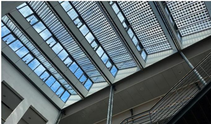
BIPV schafft mit architektonisch ansprechenden Lösungen eine hohe Akzeptanz bei Planern und Architekten, Nutzern und Anwohnern. Für die Montage der Module werden bestehende bauliche Strukturen genutzt und die Gebäudehülle teilweise ersetzt. Damit spart BIPV Baumaterial ein und leistet einen Beitrag zur Ressourceneffizienz. Werden hingegen gewöhnliche PV-Module über dem Dach montiert, dann bilden diese eine zusätzliche Ebene (Abb. 19) mit entsprechend höherem Materialeinsatz.
