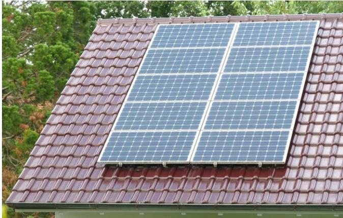
Abb. 19 Oben: BAPV-Anlage in einfacher Aufdachmontage (© Fraunhofer ISE).
