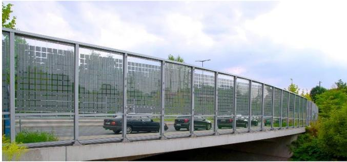
Abb. 22 Oben: Semitransparente PV-Lärmschutzwand (© R. Kohlhauer GmbH).
