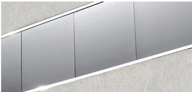
Abb. 18 Oben: Blendfreie BIPV-Kaltfassade mit unsichtbaren Solarzellen (© Fraunhofer ISE).
