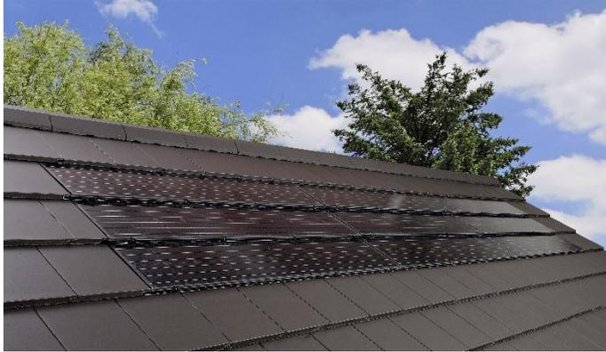
Abb. 17 Oben: BIPV als Dachpaneele (© BMI Braas).
